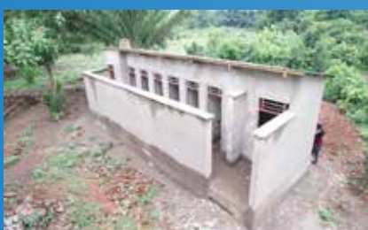
UJENZI WA MATUNDU 8 YA VYOO SHULE YA SEKONDARI NJISI
